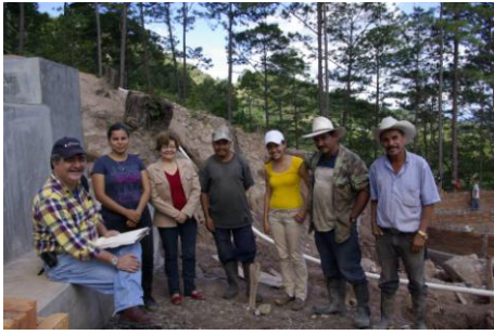
Helfer auf der Baustelle
