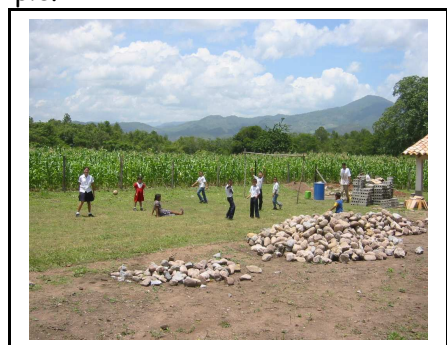
Aménagement du terrain de jeu à l'école Las Maderas
