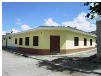
Bibliothèque après travaux
