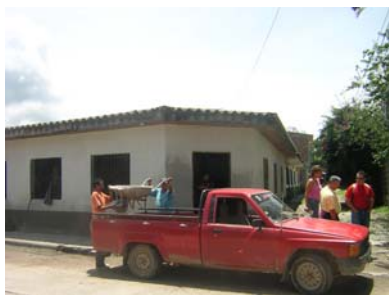
Bibliothèque avant travaux
