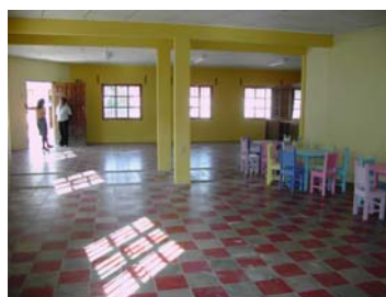
Local après les travaux
