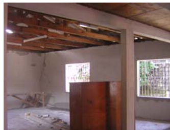
Local pendant les travaux
