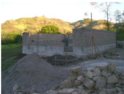
Travaux de construction de l'école d'Apintal
