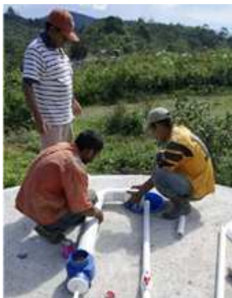
Pose du système de chloration
