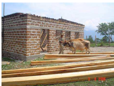
Construction de l'école de LIQUIDAMBOS en adobes avec la participation des bénéficiaires
