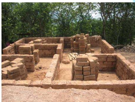
Construction de l'école de LIQUIDAMBOS en adobes avec la participation des bénéficiaires
