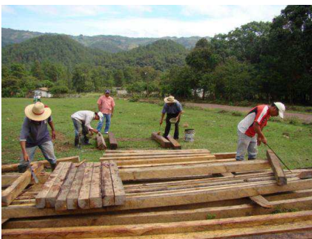
Construction de l'école de Guajarao
